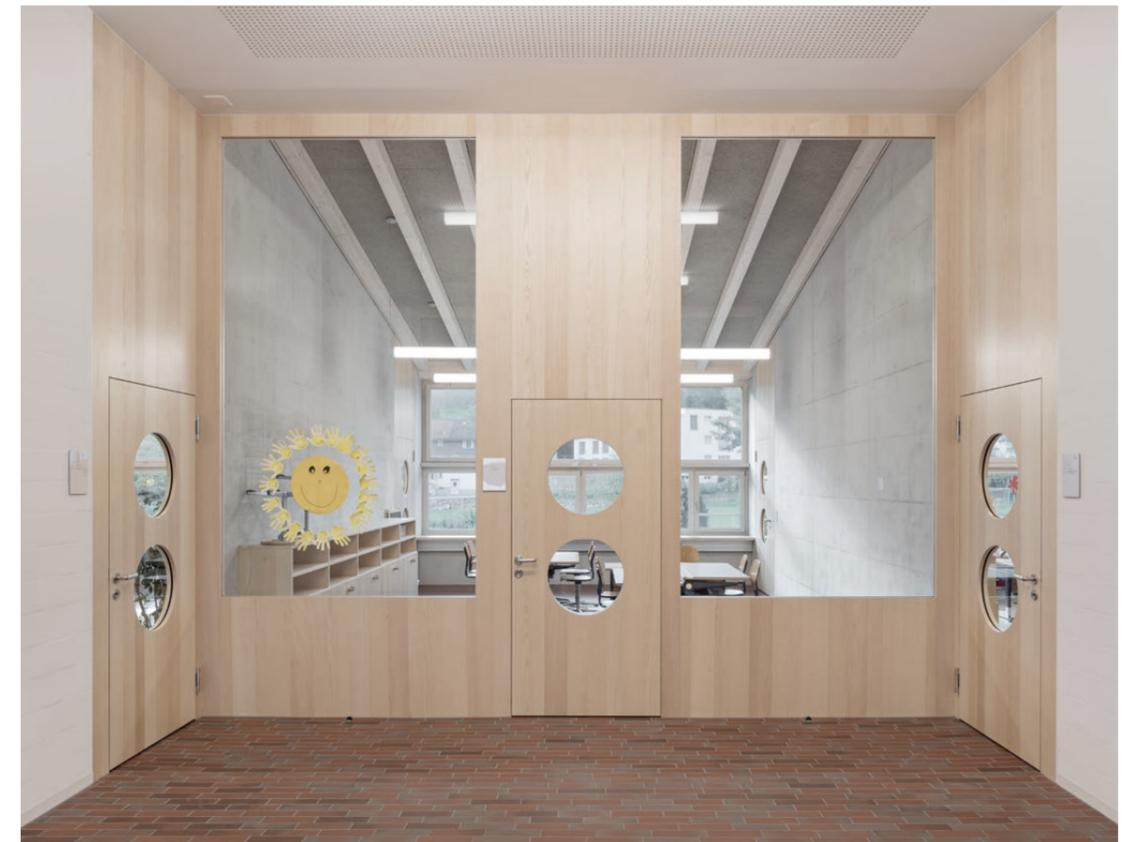
**Türelemente mit festen Seiten- und Oberteilen** müssen in der Regel die gleiche Feuerwiderstandsdauer aufweisen wie die angrenzende, brandabschnittsbildende Wand gemäss den Vorgaben der VKF-Brandschutzrichtlinie 15-15 „Brandschutzabstände, Tragwerke, Brandabschnitte“.
