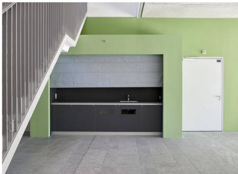
**Universität EPFL Lausanne:** Für dieses Projekt wurde ein individuell gefertigter Feuerschutzvorhang für vertikale Fluchtwege installiert – verfügbar bis zu einer Grösse von 6,24 x 5 Metern.
